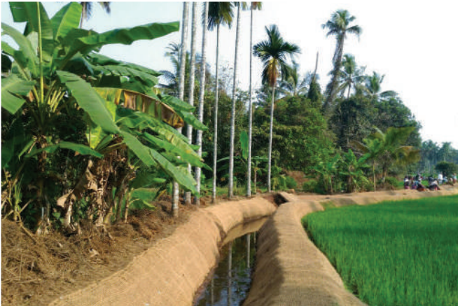
കണ്ണൂർ ജില്ലയിൽ കൊളച്ചേരി ഗ്രാമ പഞ്ചായത്തിൽ കയർ ഫെയ് നൽകിയ കയർ ഭൂവസ്ത്രം ഉപയോഗിച്ച് നടത്തിയ മണ്ണ് ജല സംരക്ഷണ പ്രവർത്തികൾ
